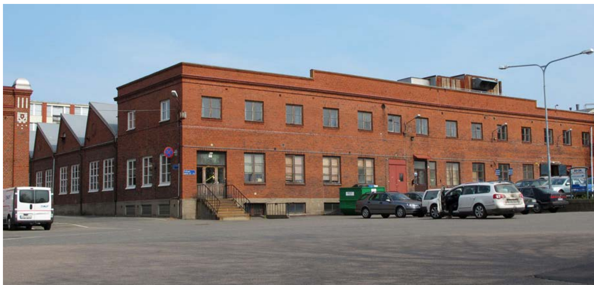
Fasad med ett förhöjt mittparti samt ursprungligt entréparti utmed Kullagergatan i vy mot norr.
