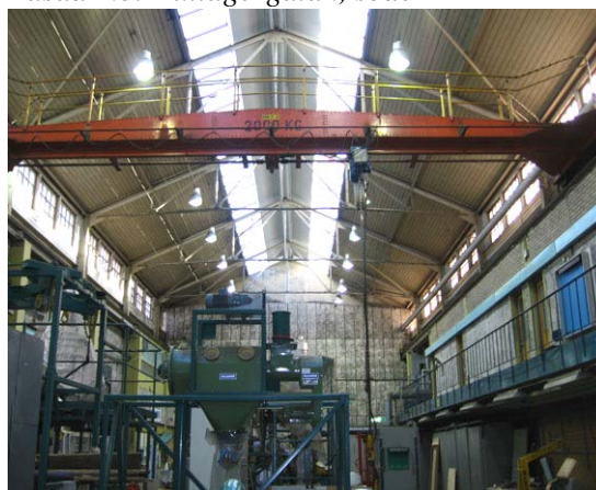
Fasad utmed Arvid Palmgrens gata. Interiör verkstadshall med travers, entersolvåning, invändigt bärverk och överljus ur Antikvarisk varsamhetsplan, Lindholm restaurering 2011-04-12.
