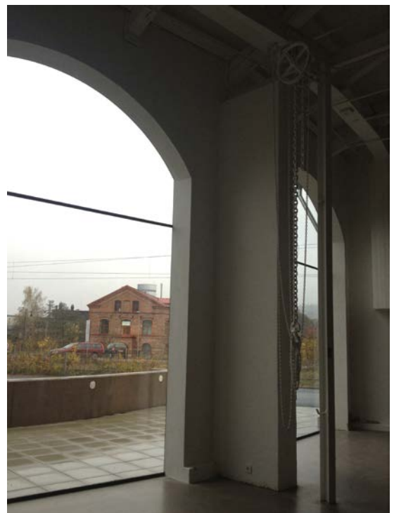
Före detta vanghallar omvandlade till utställningshallar. Större öppningar står i kontrast till den äldre bevarade gaveln. Nya glaspartier burna av tunna profiler som har infogats på ett föredömligt sätt. Invändiga detaljer som vittnar om den tidigare verksamheten har sparats vilket bidrar till förståelsen av byggnadens ursprung.
