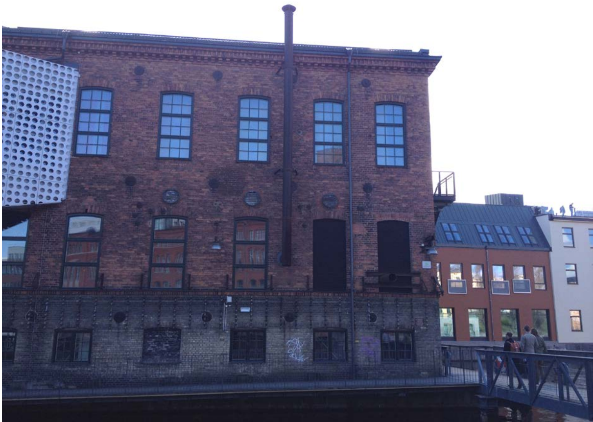
Utvändiga detaljer har lämnats i fasaden och låter berätta om industrins successiva utveckling som resulterat i små justeringar av byggnaden.
