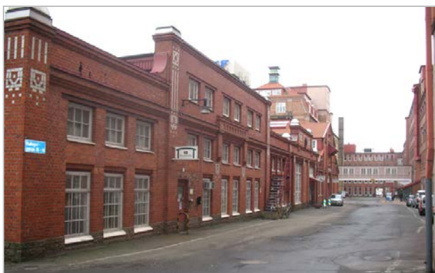
Fasad mot Rullagergatan, norr
