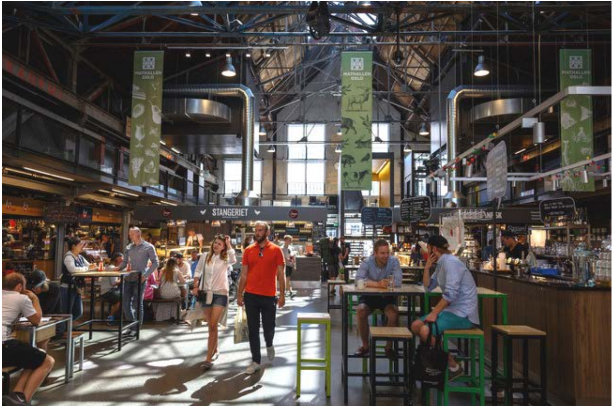
Mathallen invändigt med bevarade synligt bärverk, med överljus, rördragningar, traverser etc.
