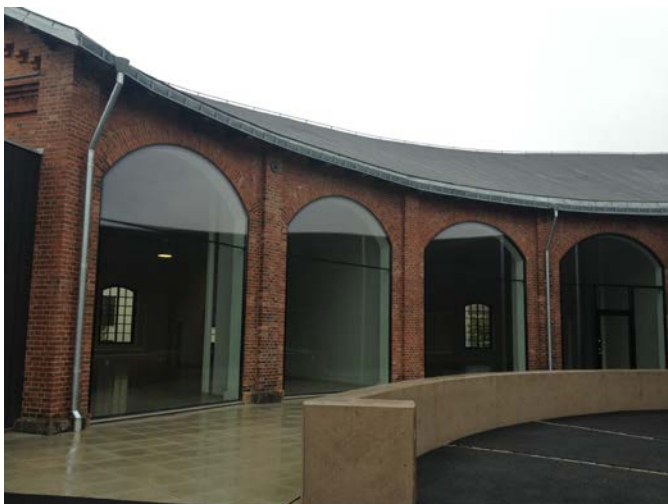
Före detta vanghallar omvandlade till utställningshallar. Större öppningar står i kontrast till den äldre bevarade gaveln. Nya glaspartier burna av tunna profiler som har infogats på ett föredömligt sätt. Invändiga detaljer som vittnar om den tidigare verksamheten har sparats vilket bidrar till förståelsen av byggnadens ursprung.
