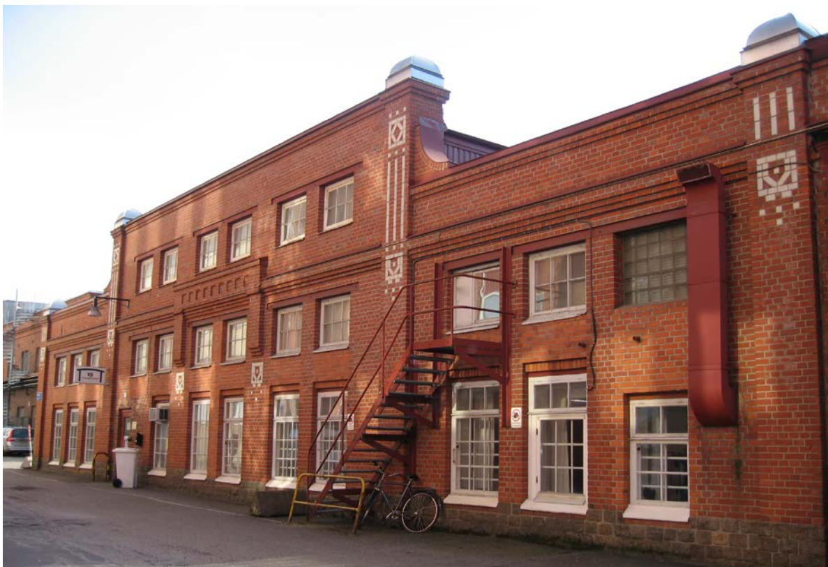
Del av M-verkstadsens fasad mot Rullagergatan.
