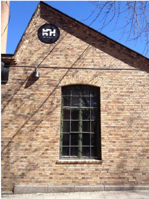
Sågtandstak med bibehållet överljus, ursprungliga fönsterbågar i stål har sparats och kompletterats med invändiga fönsterbågar av trä.
