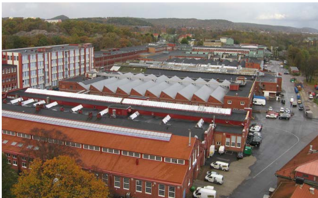
Sett från SKF:s huvudkontor. I förgrunden M-verkstaden med två basilikaformade hallar, därbakom R-fabriken med sågtandstak. Till vänster i bilden sticker K-fabriken upp i "muren" mot Artillerigatan. Till höger lastgårdar utmed Kullagergatan mot den gröna åravinen.
