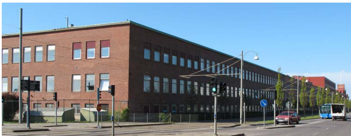
Fasader utmed Artillerigatan i vy mot väster.
