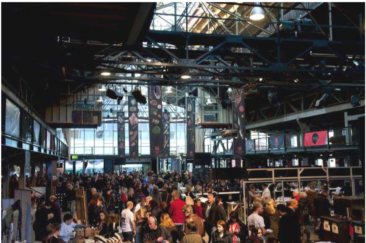
Gaveln åt söder har erhållit en ny glasad fasad och centrerat entréparti med skjutdörrar.
