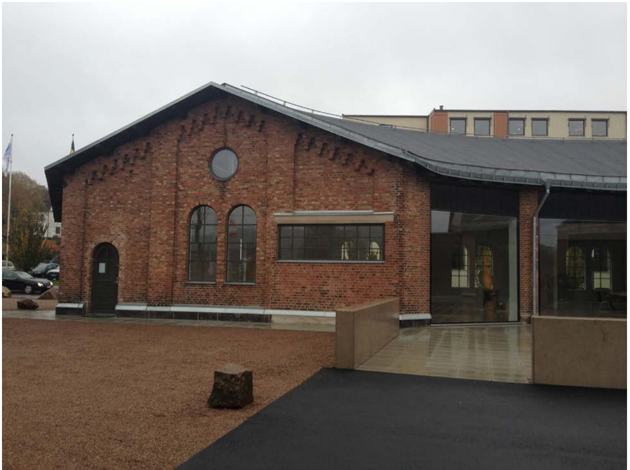
Före detta vanghallar omvandlade till utställningshallar. Större öppningar står i kontrast till den äldre bevarade gaveln. Nya glaspartier burna av tunna profiler som har infogats på ett föredömligt sätt. Invändiga detaljer som vittnar om den tidigare verksamheten har sparats vilket bidrar till förståelsen av byggnadens ursprung.
